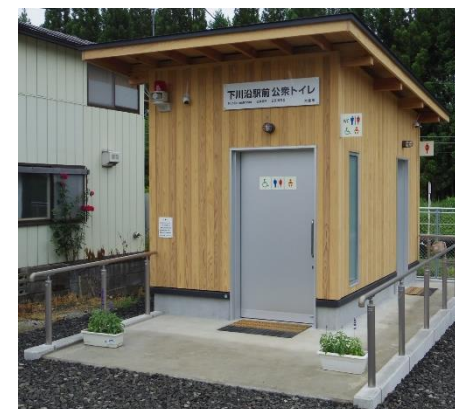
▲下川沿駅公衆トイレ▲
