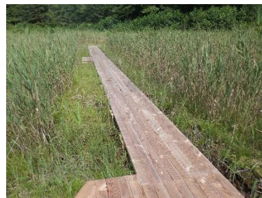
▲ウッドデッキ (R4) ▲
