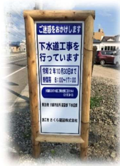
工事用看板 (間伐材)
