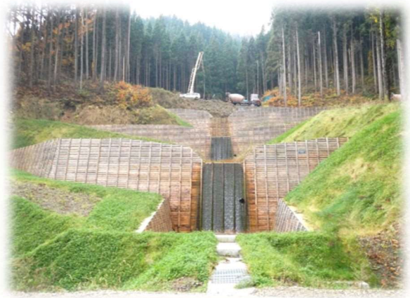
治山ダム（木製型枠）
