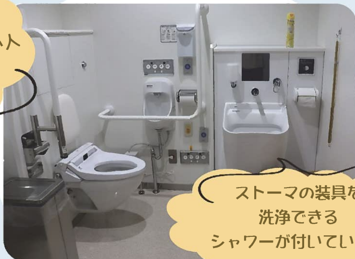
大館市役所 庁舎内2階トイレ
