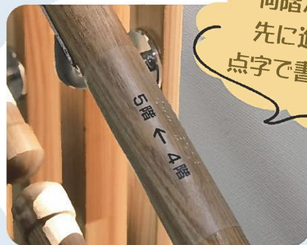
大館市役所 庁舎内
