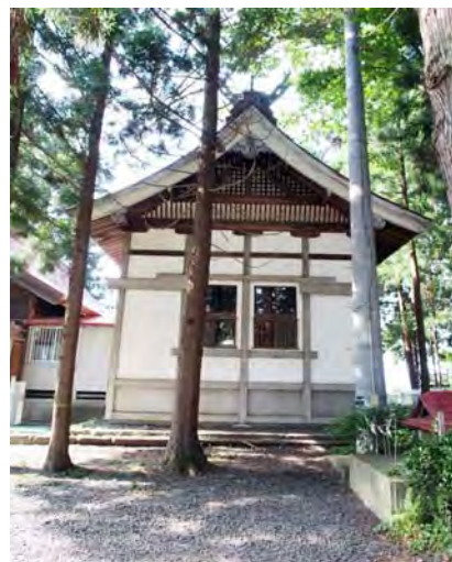
重要文化財「大館八幡神社」 本殿２社を保護する覆屋
