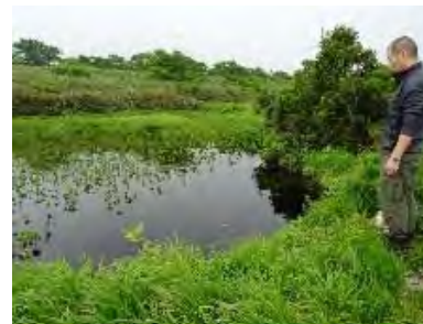
賽護打ち(沈み加減を確認)
