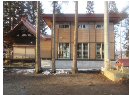
重要文化財「大館八幡神社」 本殿2社を保護する覆屋 (建替後完成写真)
