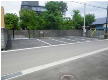
駐車場舗装工
