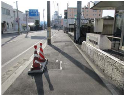
電線共同溝本体工事【上り線】 (着手前)
