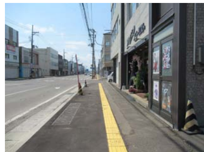
電線共同溝本体工事(完了後) 歩道部舗装の美化化及び抜柱は 次年度以降に施工予定
