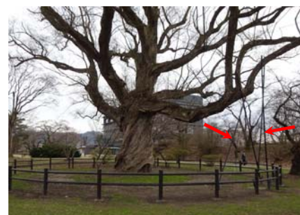
シロヤナギ枝折れ対策支柱設置
