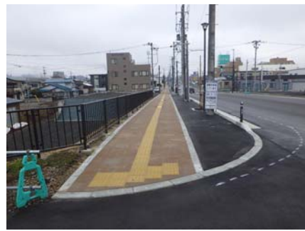
歩道融雪設備工事(完了後 抜柱は令和6年度以降に 施工予定)
