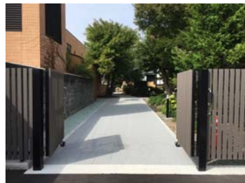
木塀改修工・平板敷工
