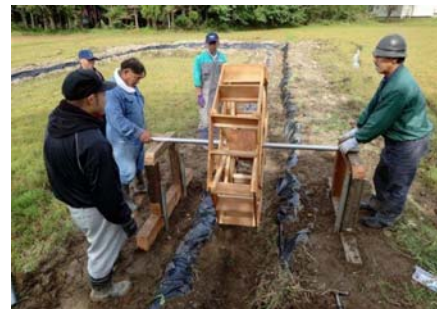
上段: 水車の組立製作 下段: 水車の現場設置 (駒橋会)
