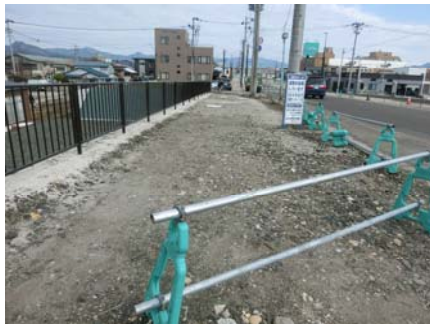
歩道融雪設備工事(着手前)
