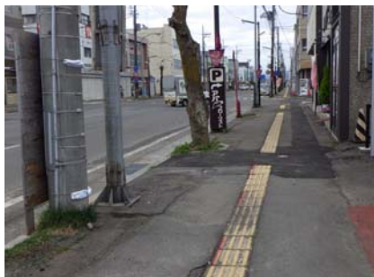
電線共同溝本体工事(着手前)
