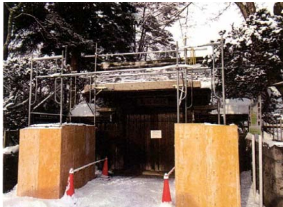
修繕作業状況(足場設置)
