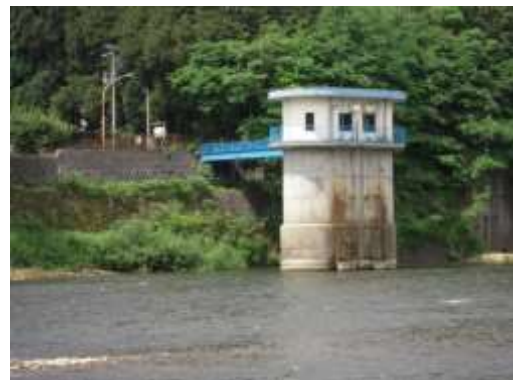
本道端取水塔
