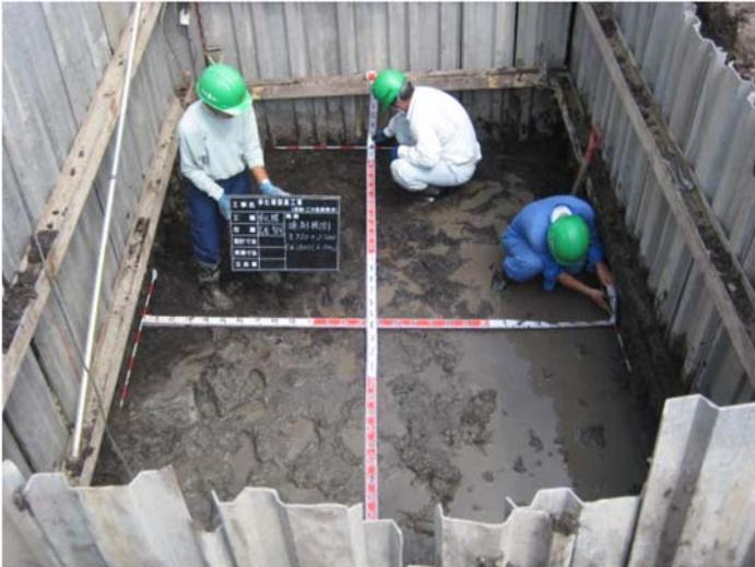
②掘削寸法（長さ、幅、深さ）が
