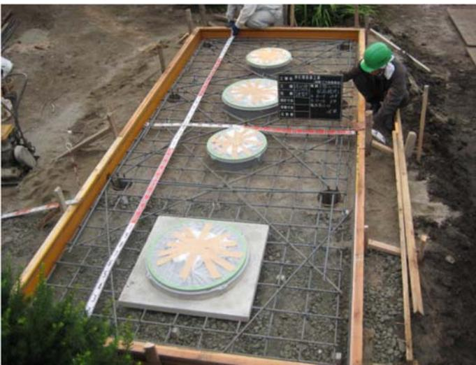
⑫配筋寸法・配筋状態・型枠・スペーサーの使用が確認できる写真
