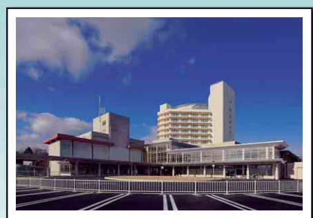
▲市立総合病院の改築工事が完了 (平成21年3月)
