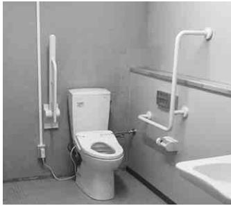
⑤手すりなどを整備した長根山運動公園のトイレ
