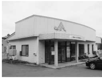
花矢図書館として利用されるJAあきた北花岡営業支店跡地
