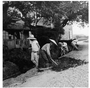
土管を入れて排水もこれで大丈夫
