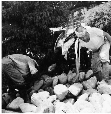
石を運ぶのも手作業です
