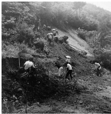
土手の土も近くの山から掘り出しました
