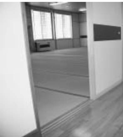
敷居の段差が無い内部
