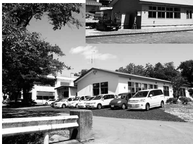
花岡中学校 管理棟
