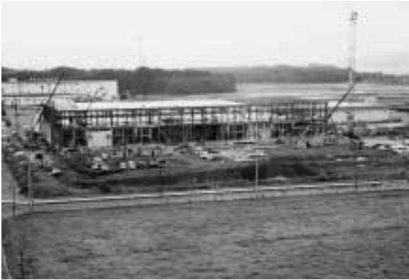
増設工事が進むニプロファーマ(株)
