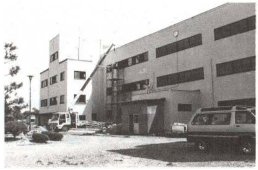
◀校舎内部の改修工事が行われている南中学校
