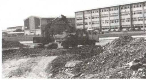
▶急ピッチで工事が進められている東中学校グラウンド
