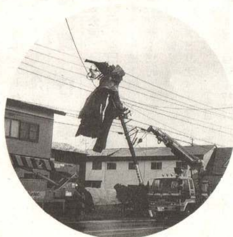
▶ 屋根からはがれたトタンが絡まった電柱（片山2丁目国道7号沿い）
