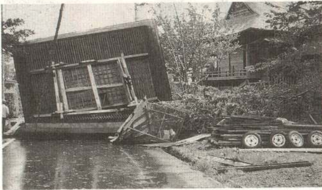
強風に吹き飛ばされ、県道に落下した立花神社の屋根
