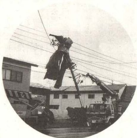
▶ 屋根からはがれたトタンが絡まった電柱（片山2丁目国道7号沿い）
