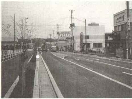
拡幅工事が完了した沼館線の三百メートル区間
