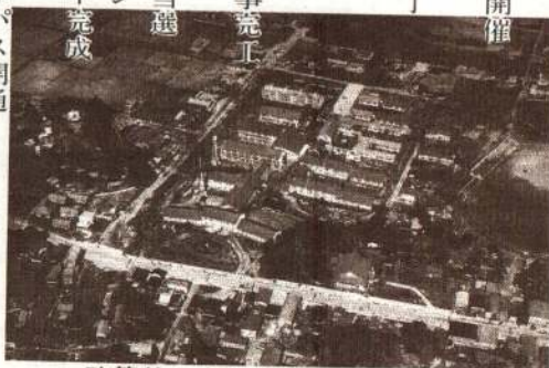
改築前の市立総合病院
