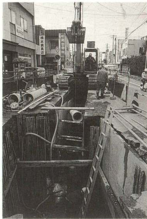
市の中心部で着々と進む下水道管敷設工事
