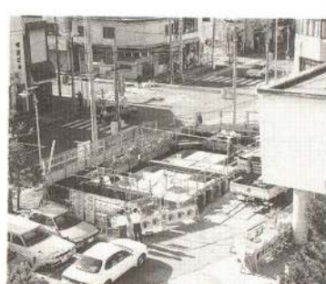
市役所前に建設中のポンプ室
