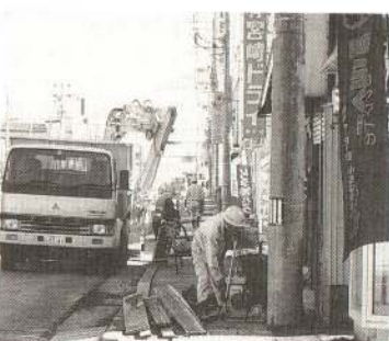
有浦・御成町は片側がほぼ完成しています
