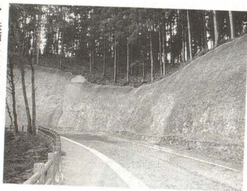
▶ 法面には芝を張り付けます
