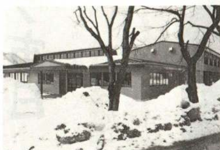
▲花岡保育所隣りに建設された公民館 (花岡公民館 ☎46-1161)
