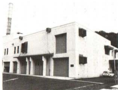
▲1日160klのし尿を処理する処理施設
