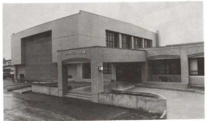
▲建物の外壁は、文化会館と同じ薄いベージュ色です。
