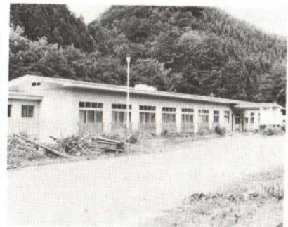
▲改修をする老人福祉センター
