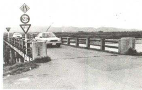
▲架け替えられる二井田大橋
