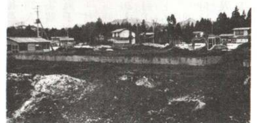
▲ニッ森地内に建設中のシャインソーエイト
