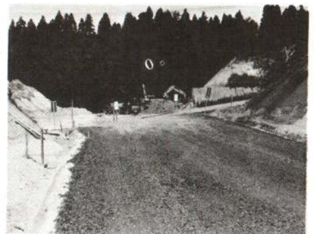
◀工事が進む第一工区(山館)
