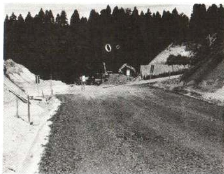
▲工事が進む第一工区(山館)
