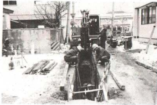
▶南神明町での下水道工事
