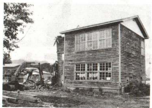
解体工事中の二井田公民館麓西分館
