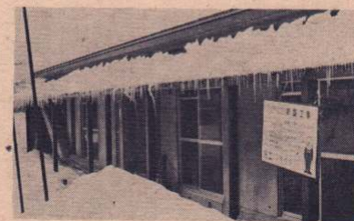
急ピッチで工事中の身体障害者用住宅
