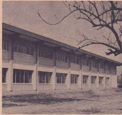
完成した市立総合病院「放射線棟」
