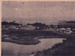
陸上競技場を建設中の長根山運動公園（右が野球場）
