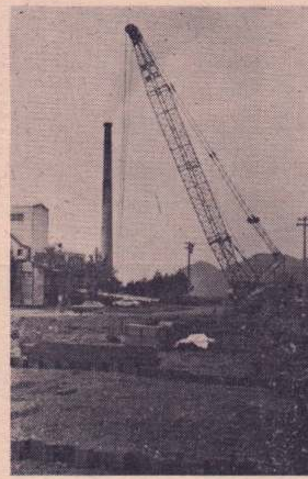
基礎工事中のゴミ焼却場
