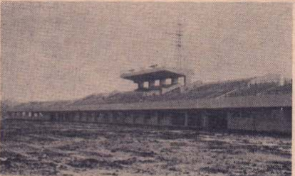
長根山総合運動公園の最終事業である「陸上競技場」の新築工事は、今年三月末でメインスタンド（正面観覧席）とサブスタンド（付属観覧席）が完成しました。
