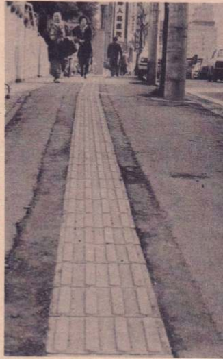
一部完成した点字歩道(長倉町)
