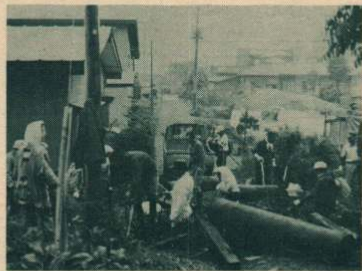
▲住民総出で下水路を補修
