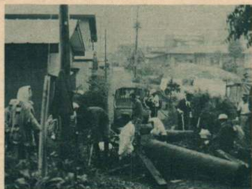
▲住民総出で下水路を補修
