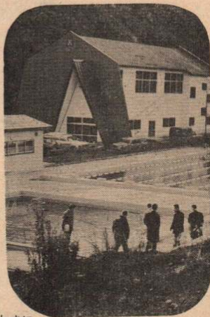
→ プールわきに 完成した200 名収容できる 休けい所
