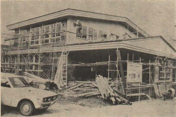
(写真) 11月5日現在 十二所公民館の新築工事
