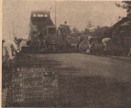
着々とすすむ市道舗装工事
