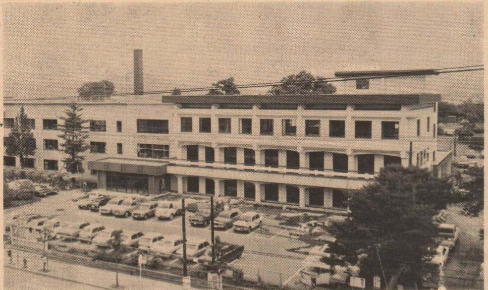
現庁舎東側に完成した増築庁舎
