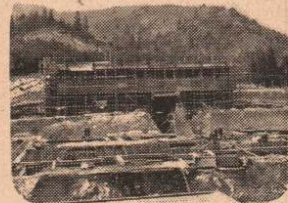
▶工事中の山館新浄水場
