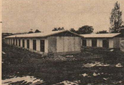
急ピッチで工事中の市営住宅
