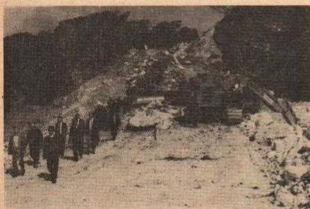
現在工事中の区域を踏査する同盟会の一行
