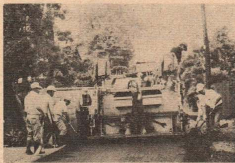
市道の舗装工事
